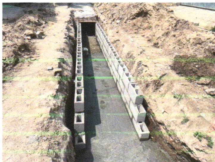
Foto 04 - ALVENARIA DE BLOCOS DE CONCRETO ESTRUTURAL 14X19X39 CM, (ESPESSURA 14 CM) FBK = 14,0 MPA, PARA PAREDES COM ÁREA LÍQUIDA MENOR QUE 6M 2 , SEM VÃOS, UTILIZANDO PALHETA. AF_12/2014
